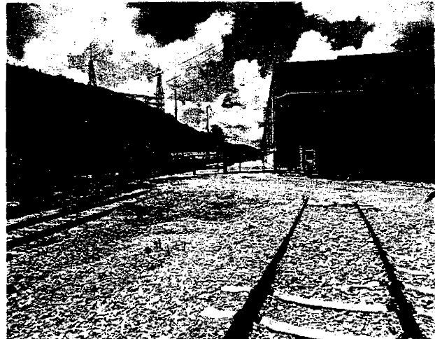
Теренът южно от УПИ XIV-74 – изглед в посока от югоизток на запад
